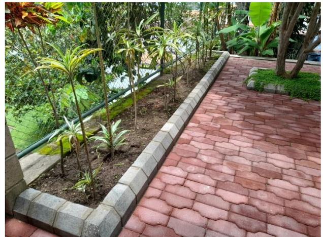
Si el bordillo se va a utilizar para conformar una jardinera, no se requiere de una Base de Suelo cemento, pues se coloca sobre el suelo compactado.
